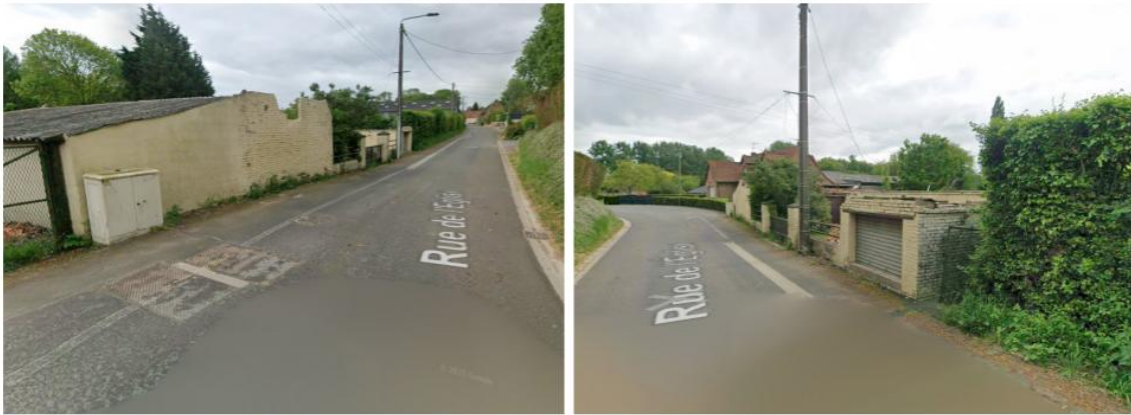
Façades côté rue de l'ancienne ferme, de part et d'autre de la rue de l'Église La ferme est en cours de démolition.
