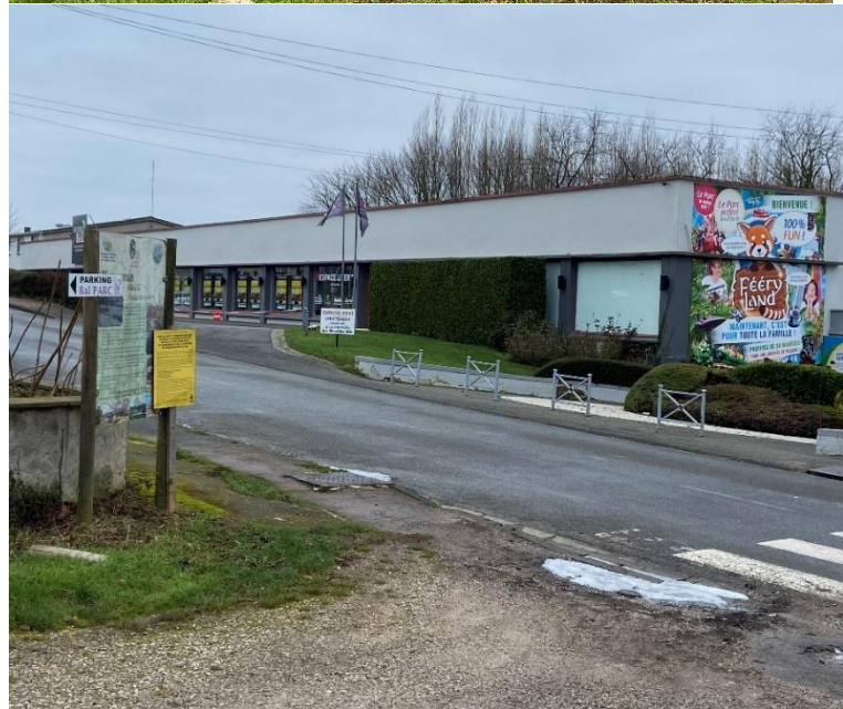
2 photos au Nord du site, rue du vieux château
