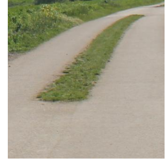
Bande enherbée centrale et bande de roulement
