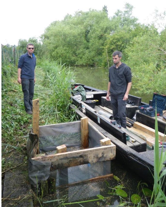
remplacement de la connexion entre l'étang et le Zieux
