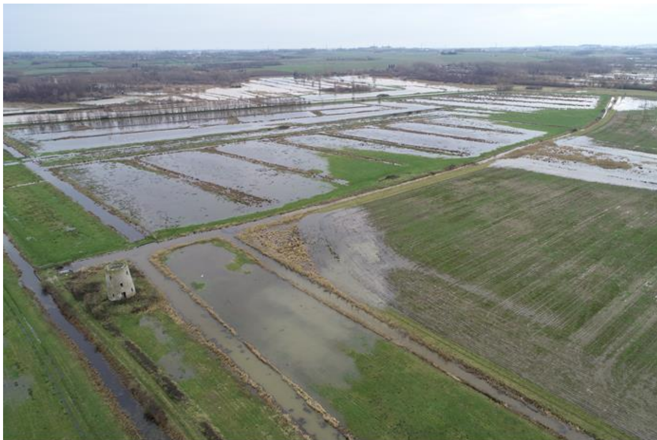
Vue sur la partie est de la ferme durant l'hiver 2020-2021 / côte d'eau 2m24
