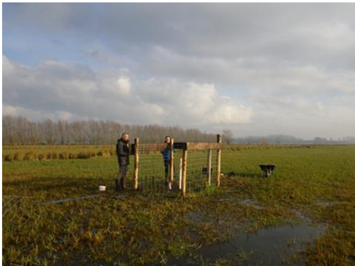
Implantation d'un limnimètre sur les prairies de la ferme du Zuidbrouck – décembre 2020
