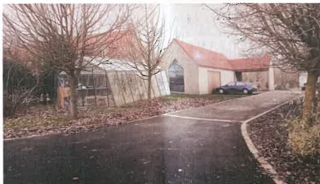
Photo-montage issue du PC de 2017 . La serre et l'accès en enrobé sont déjà réalisés.
